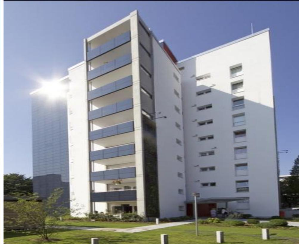
Vorgehängte hinterlüftete oder gedämmte CIGS-PV-Module (CupferIndiumGalliumSulfid).
